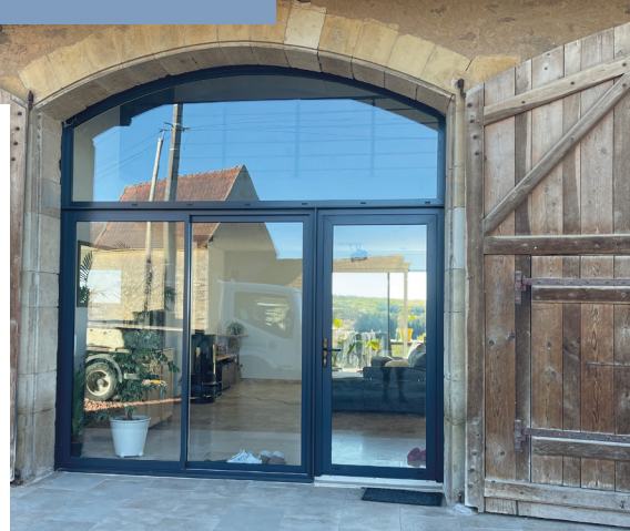
portes battantes permettant de limiter les apports solaires en été et d'ajouter une isolation en hiver.
