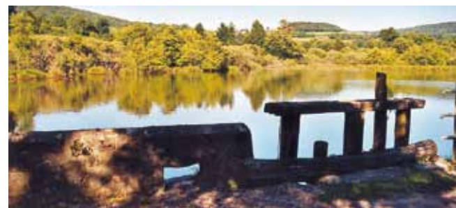
Digue à l'étang de Cherières (Lormes)
