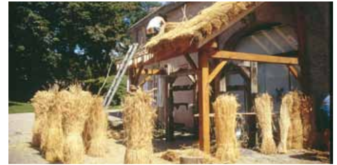
Démonstration de toit en seigle à St-Brisson
