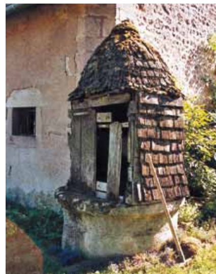
Puits à Saint-Léger-sous-Beuvray
