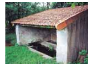
Lavoir rénové à Brassy (Brizon)
