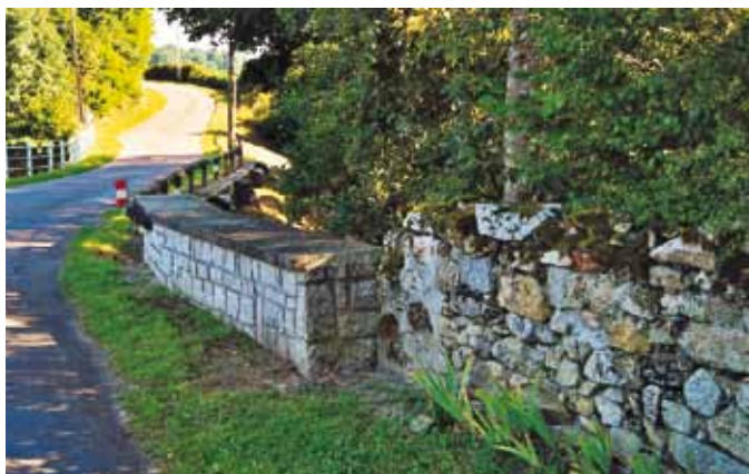
Muret de la digue de l'étang de Cherières (Lormes)
