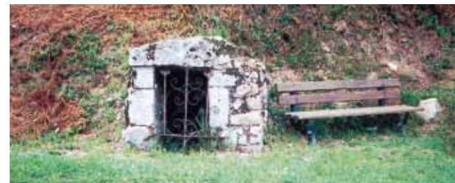
Fontaine à Planches-en-Morvan
