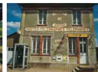
Façade de poste à Chissey
