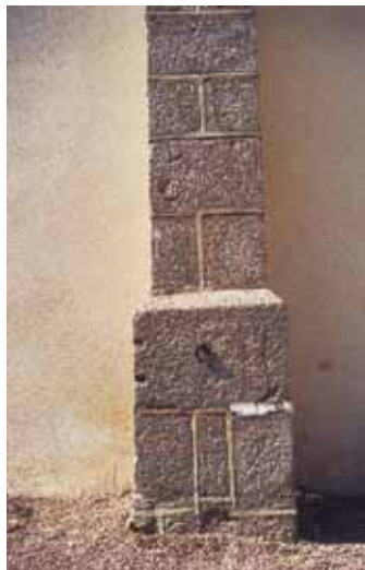
Anneau sur contrefort de l'église à Marigny-l'Église
