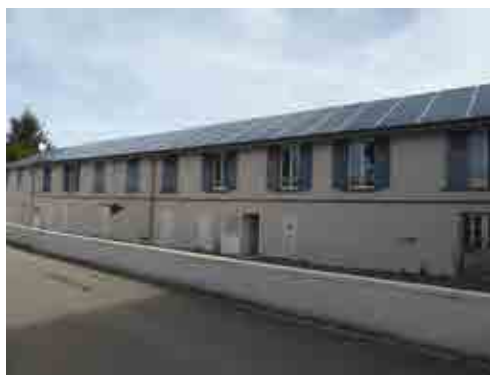
Exemple de production d'énergie solaire photovoltaïque en toiture @E. Perrussel - PNRM
