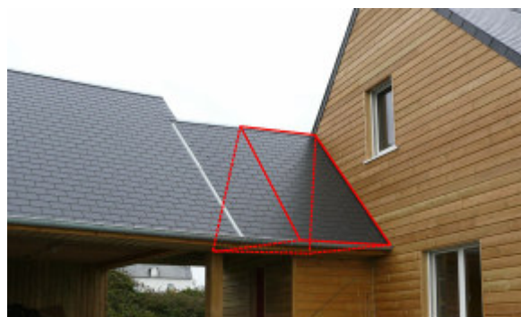
Exemple d'aménagement sur une construction neuve permettant de rendre un espace perdu (en rouge) accessible aux chauves-souris
