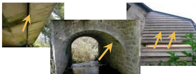
Quelques exemples d'interstices occupés (maçonnerie et bardage)
