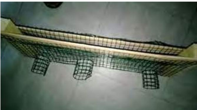
Dispositif anti-retour encastré dans le disjoints avec bouchage provisoire autour
