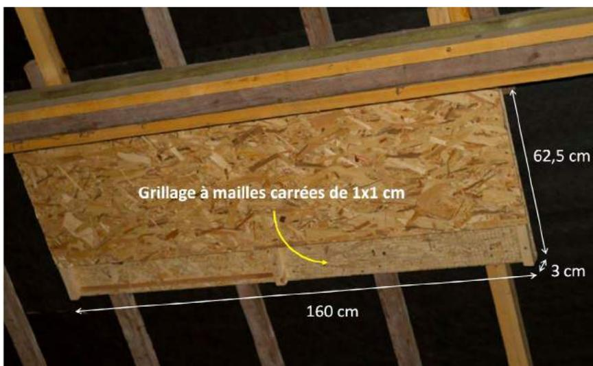
Gîte à oreillards constitué de plaques OSB, dont l'une est recouverte à l'intérieur d'un grillage
