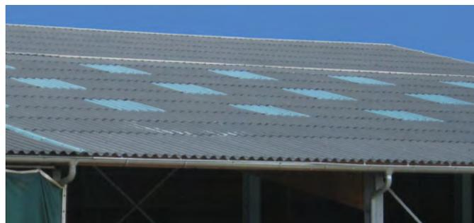
750 m<sup>2</sup> de toiture transformés en capteurs solaires à air chaud (pose de caissons en bois en sous-toiture)
