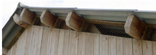
Entrée de l'air sous la toiture (côté nord)
