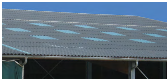
750 m 2 de toiture transformés en capteurs solaires à air chaud (pose de caissons en bois en sous-toiture)
