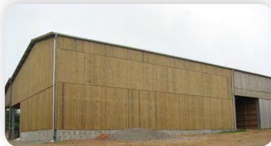
La prochaine extension du hangar va permettre de doubler la capacité de séchage et de stockage
