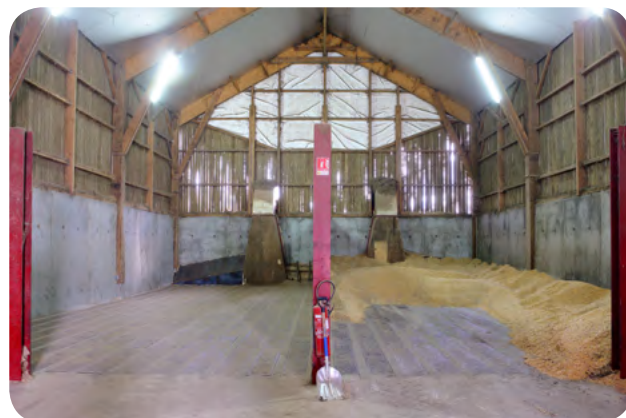
Vue intérieure du bâtiment (aires de séchage)
