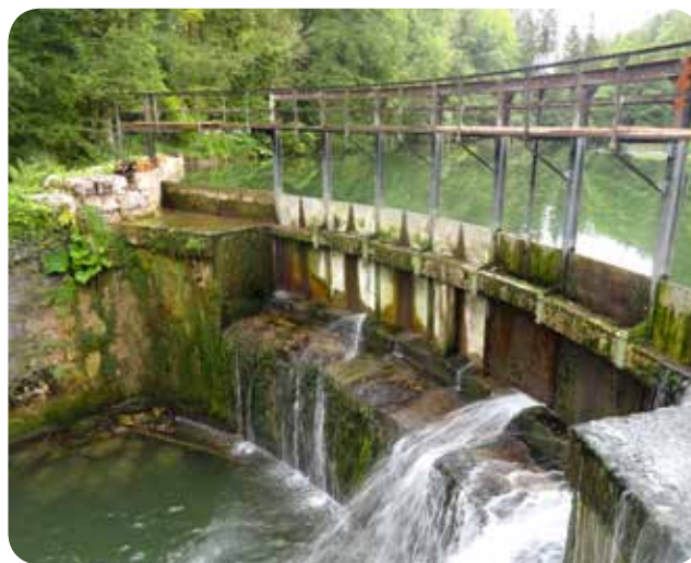
▷ Retenue de prise d'eau - Centrale de Clairvaux-les-Lacs (39) Avec une hauteur de chute de 14,50 m et 450 m de conduite, la centrale de 220 kW produit jusqu'à 1 150 000 kWh/an.
