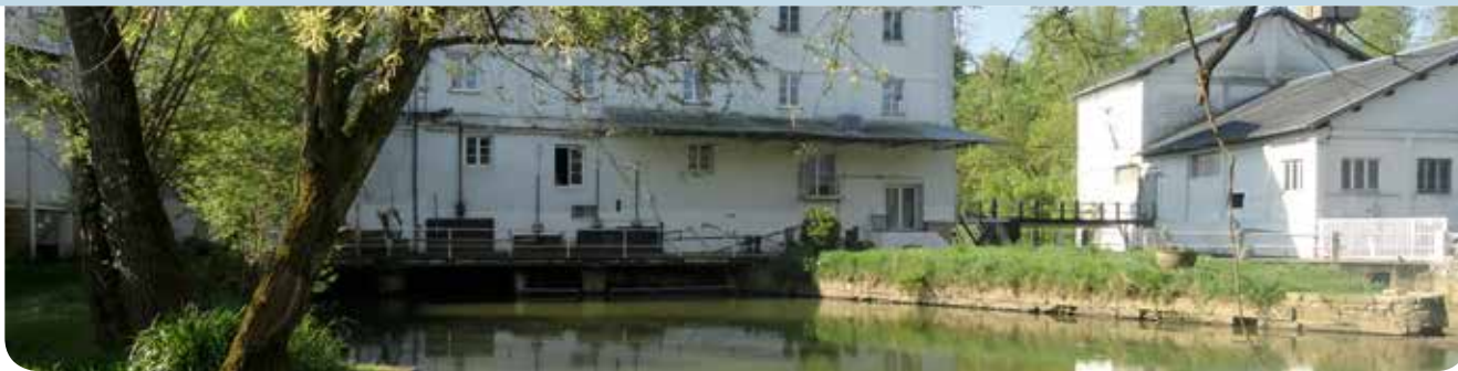
▷ Prise d'eau du moulin Cochard - Cuisery (71)
