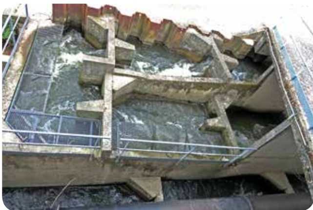
➤ Passe à poissons – Usine hydroélectrique de Decize (58)
