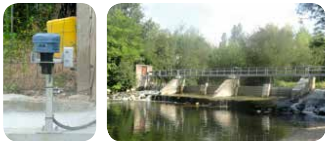
▷ Sonde de niveau et vannes au barrage – Moulin de Champdôtre (21)
