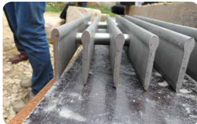
▷ Grille à faible espacement avec un profil « en têtard » limitant les pertes de charge
