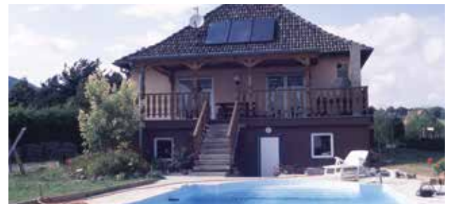
Cette maison alsacienne utilise la chaleur produite en excès pour chauffer sa piscine.
