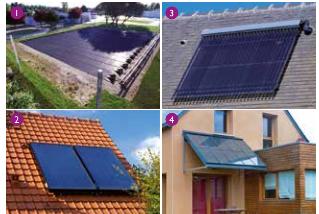
1 capteurs souples sur une piscine 3 et 4 capteurs à tube sous vide. 2 capteurs plans vitrés
