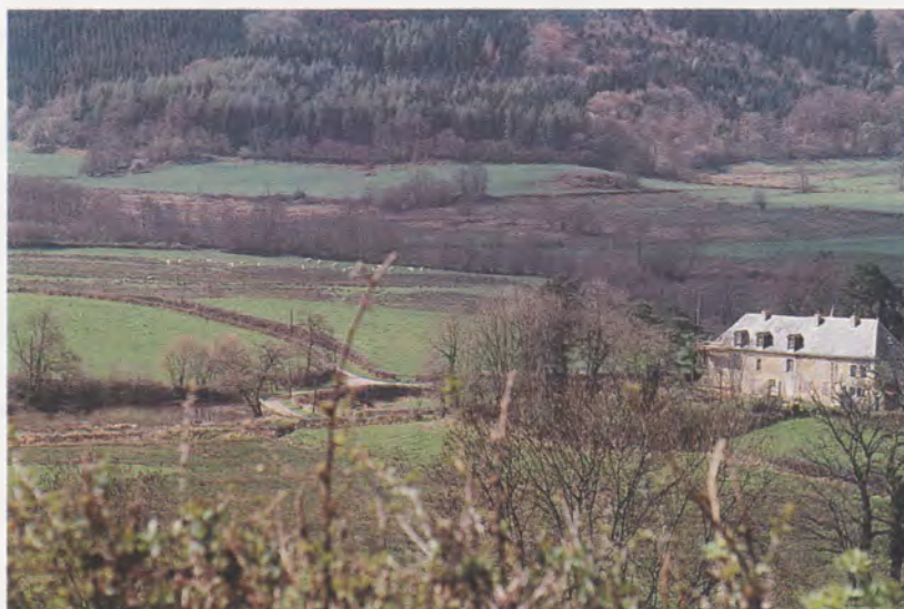
Cette vallée constitue un couloir visuel et fonctionnel. Sa fermeture par enfrichement ou par plantation provoquera à terme la fermeture des versants actuellement ouverts.
